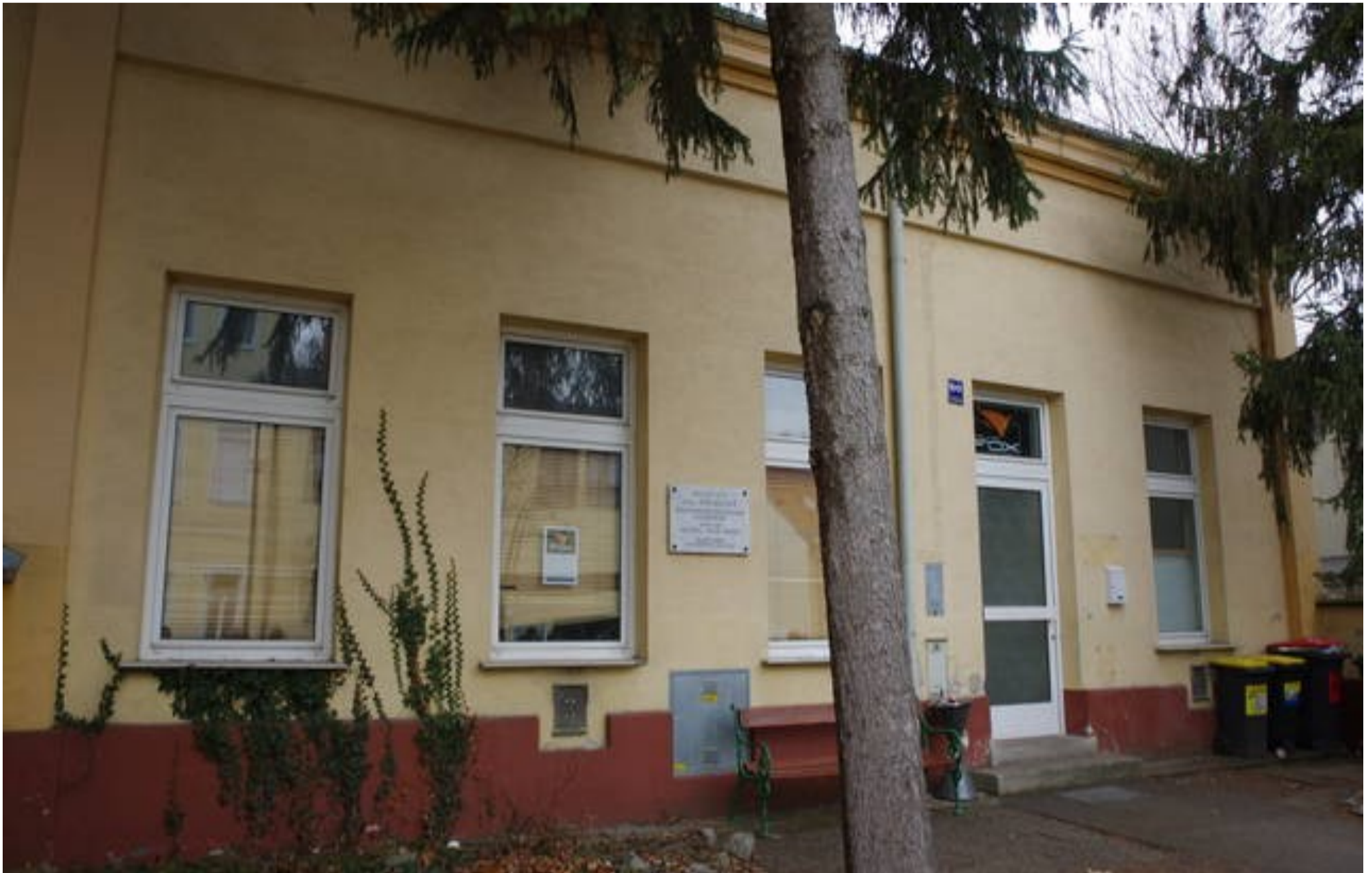
Die ehemalige Synagoge auf der Bahnstraße: Das desolante Gebäude soll im Sommer abgerissen werden. Foto Mattes
